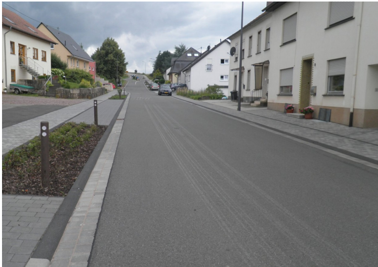
Neue Ortsdurchfahrt 2017, Mettlacher Straße
